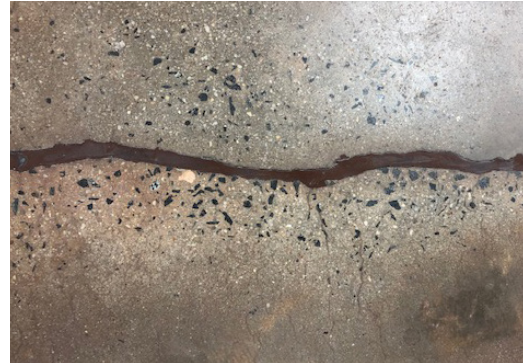
Pisos con grietas reparadas que no han sido coloreado con Diama-TLC
